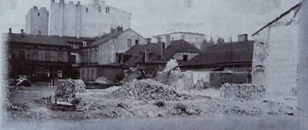
Rozbitka mroźnika, ul. Kilińskiego i Armii Czerwonej, pod budowę SDH. Foto: Marek Bigoszewski
